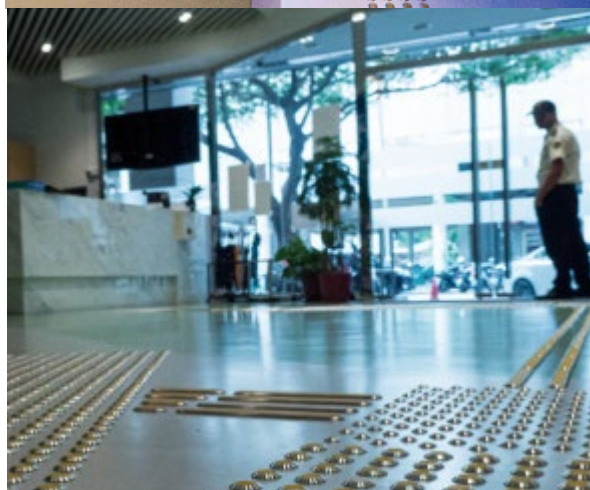
Instalação de superfície táctil
